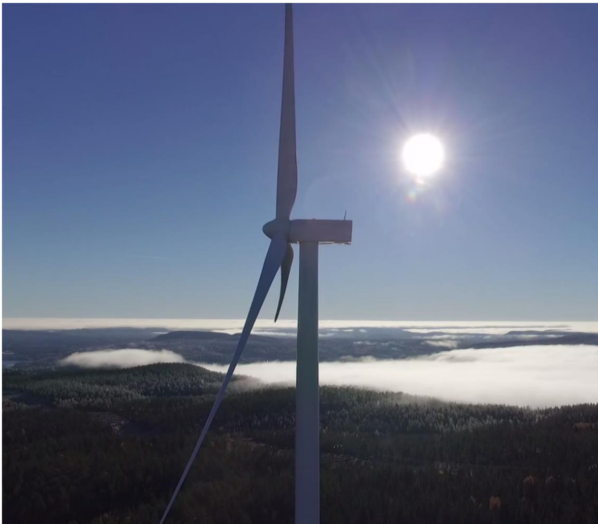
Figur 96. Fotografi på vindkraftverk i vindkraftpark Rammeldalsberget i Kramfors kommun © Uhlín Media AB
