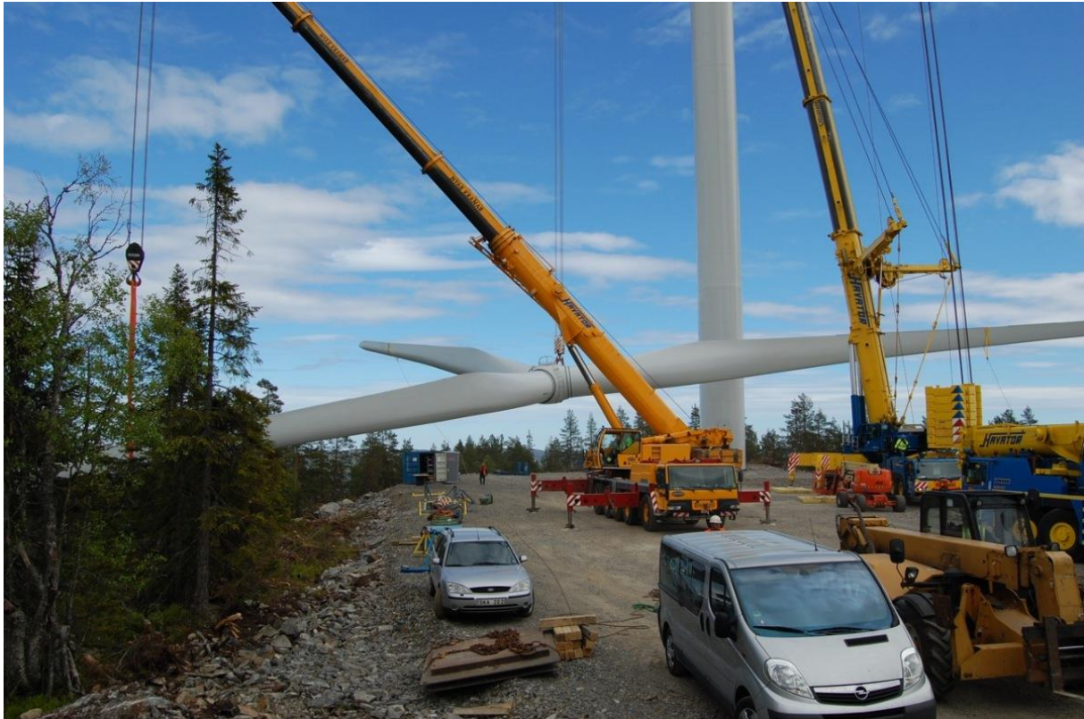
Figur 70. Fotografi som visar när en rotor lyfts med två lyftkranar
