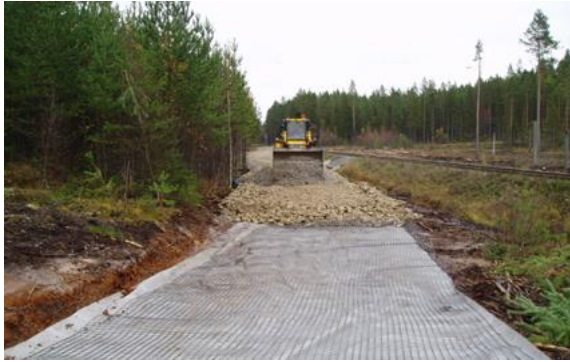
Figur 77. Byggnation av väg med geonät
