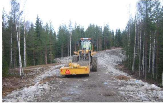
Figur 78. Byggnation av väg med synlig överbyggnad
