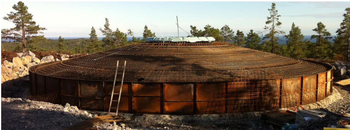
Figur 69. Fotografi på ett gravitationsfundament under konstruktion
