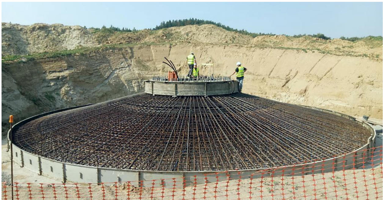
Figur 24. Byggnation av fundament
