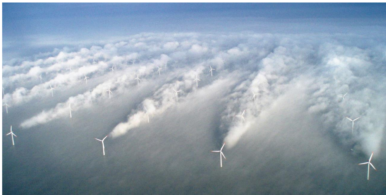
Figur 22. Fotografi på vindkraftspark Horns Rev i havet utanför Danmark. Vindvakar bakom vindkraftverk kan avslöjas vid lätt dimma.
