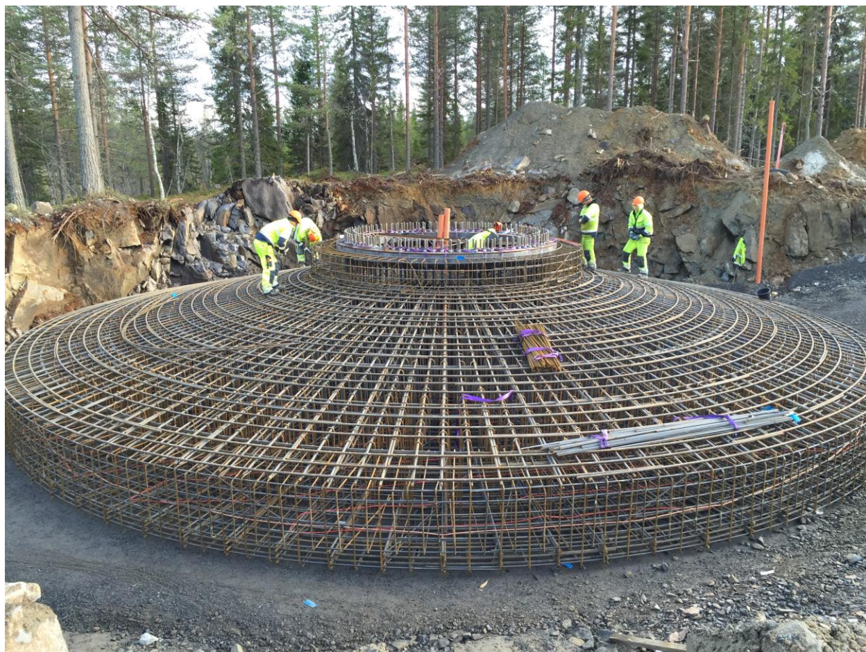
Figur 29. Armering av vindkraftverk vid Rödshöjden
